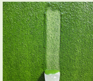
"BIOFILM" INMOVILIZADO SOBRE PANEL DE GEOTEXTIL
